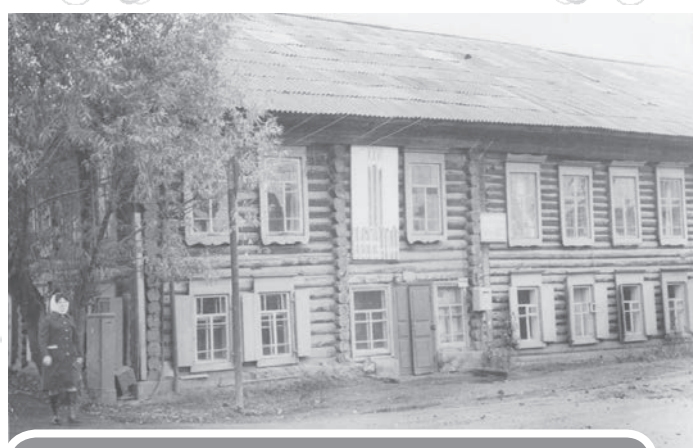
Здание почты (главный вход с ул. Майской)
