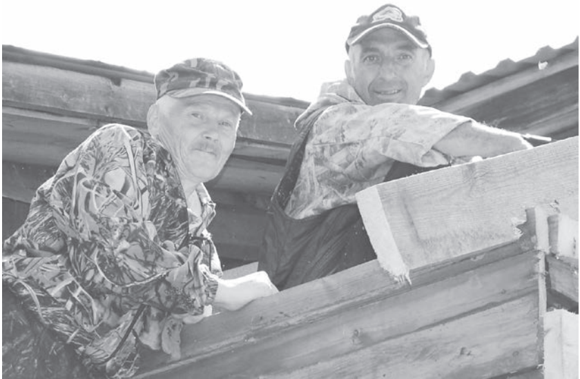
Геннадий Бегиашвили и Александр Дмитриев заканчивают ремонт крыши СДК
