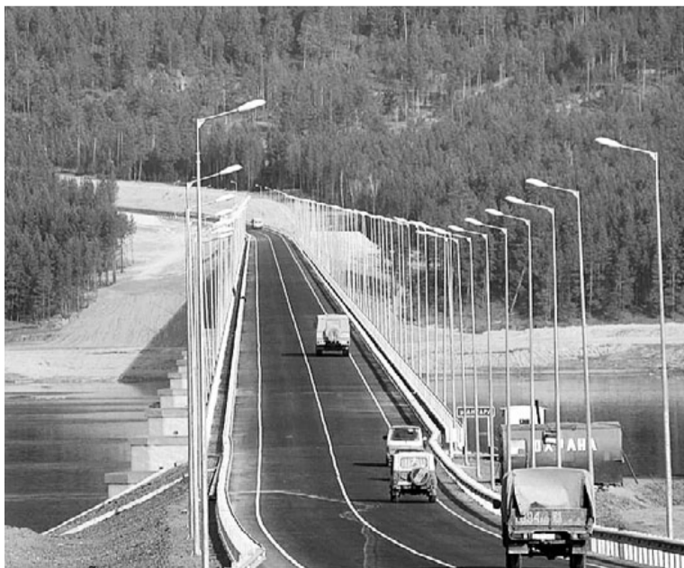
Мост через Ангару
