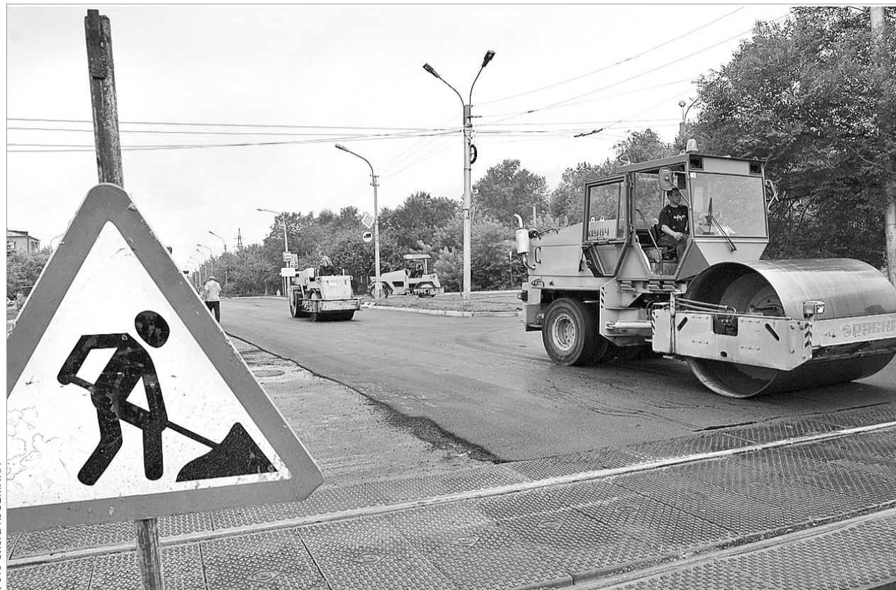
По поручению губернатора края расходы на дорожное строительство возрастут более чем на 1 млрд рублей
