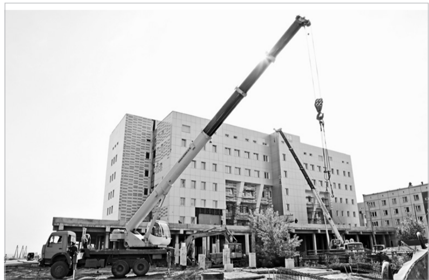
Строительство первой очереди онкоцентра завершается. В феврале 2014-го онкоцентр должен принять первого пациента
